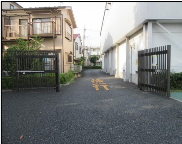
3 駐車場入口 (帰り)
